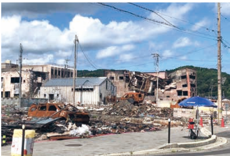
輪島市 朝市の火災現場の様子
